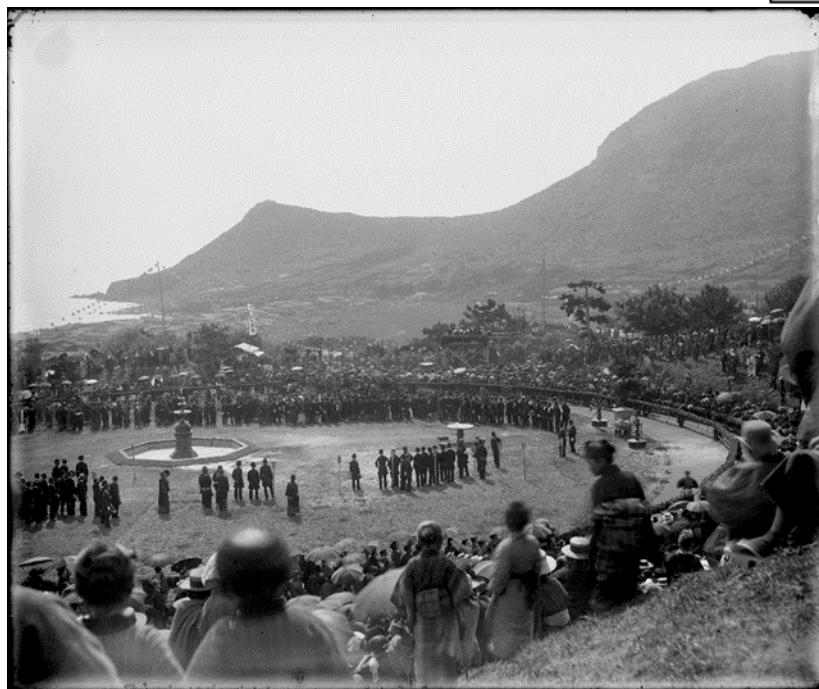
水道工事写真 水道疎水式 (ph750068-0010)
